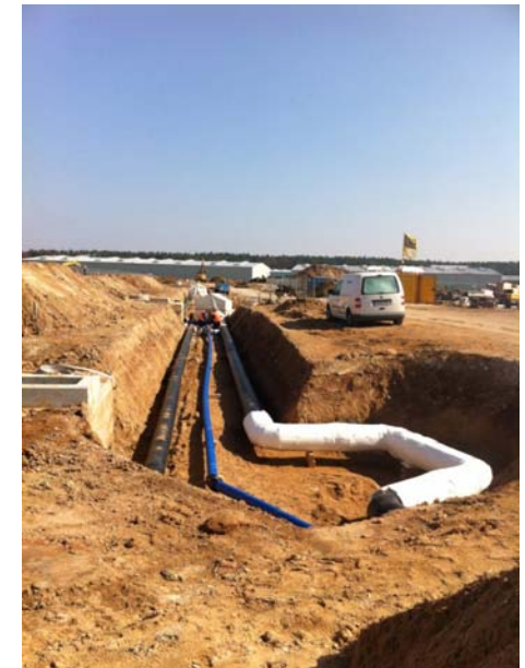
Verlegung wassergebundene Medien (LW, TW, FW)
