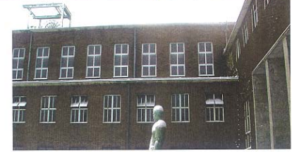
Bild 3 Das ehemalige Kauen- und Verwaltungsgebäude wird nach der Sanierung als Bürogebäude und Museum genutzt.
