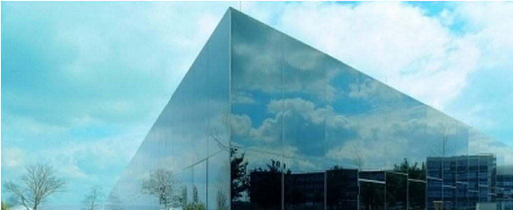
Gebäude im Campus North
